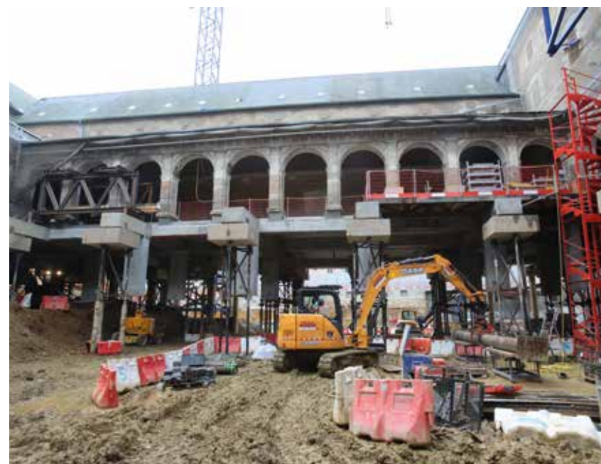
Travaux du centre des congrès de Rennes (cliché D. Gouray - Rennes ville et métropole 2014)
